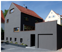
Verbundsystem verputzt, beklebt
