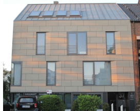
Hinterlüftete Bekleidung (evtl. auch verputzt)
